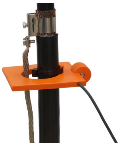
Bild 9: Montage des Phasenstromwandlers
