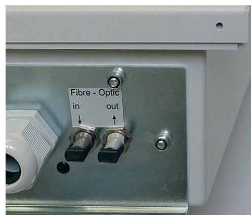
Lichtwellenleiteranschluss (ST-Technik, V17, V19)
